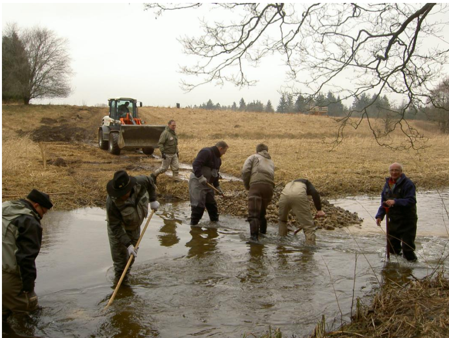
Grusudlægning i mindre vandløb
